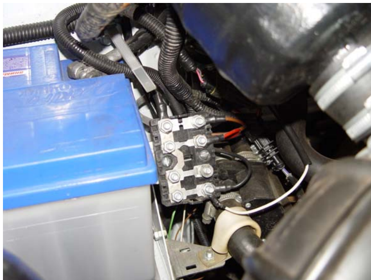
Рис. 2.13. Установка блока предохранителей БПР-4
