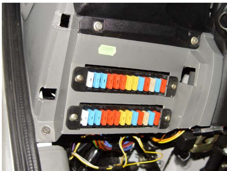
Рис. 2.14. Установка блока предохранителей БПР-13
